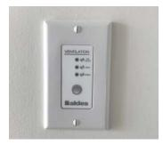
Lorsqu'il est mis en marche, l'échangeur d'air démarre de façon simultanée aussitôt avec le ventilateur de la salle de bain. C'est normal car ils sont reliés. L'un apporte de l'air frais et l'autre évacue l'air simultanément.
