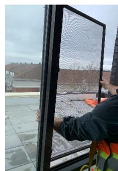
Refaire la procédure inverse pour remettre le tout en place après le lavage de vitre. Ne pas visser excessivement la vis qui bloque le bras de retenue, une simple pression suffit. **Il est de votre responsabilité de remettre le bras de retenue en place tel que l'exige le code du bâtiment.**
