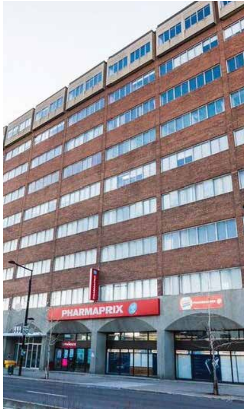
Façade (vue de côté)
